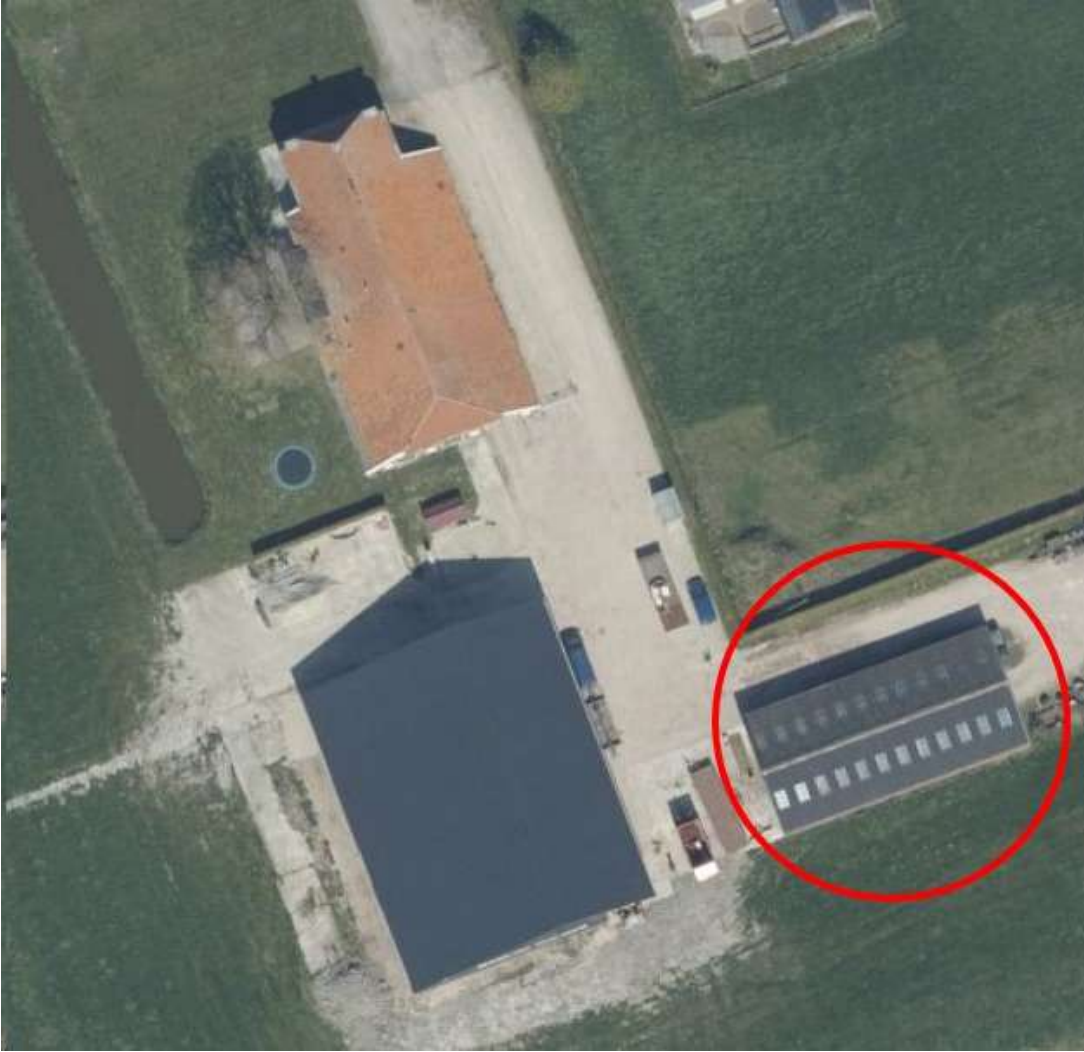
Figuur 2.1 Luchtfoto van het erf en met het rood aangegeven de te slopen schuur (bron: PDOK)
