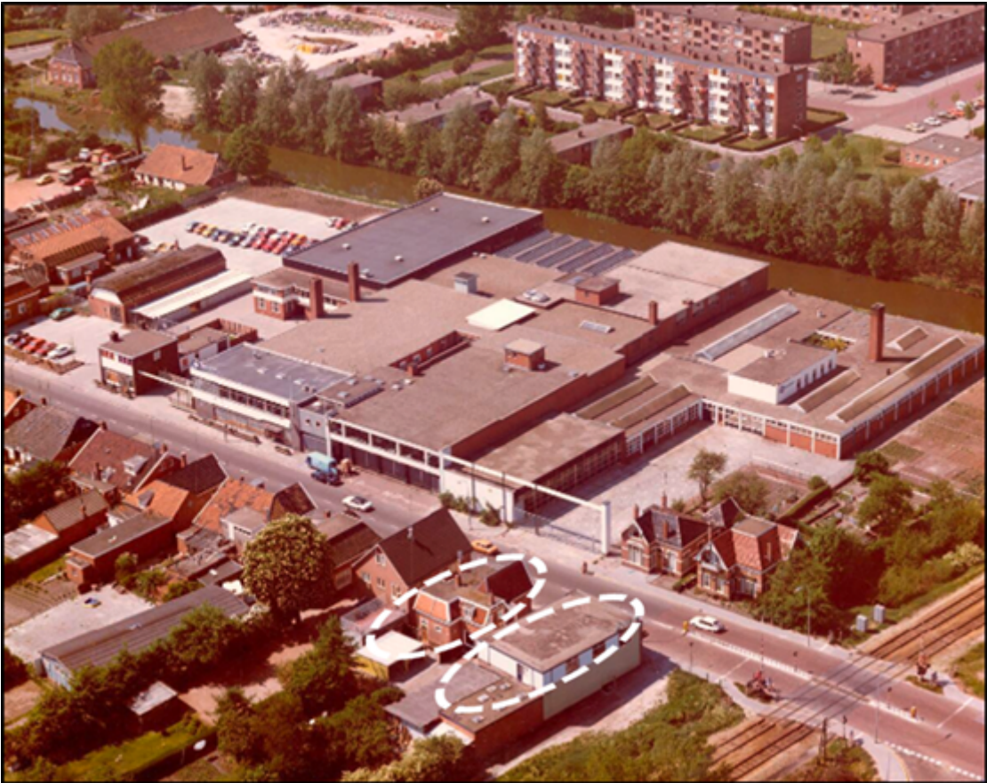
Afbeelding 5 - Vogelvluchtbeeld op de voormalige bebouwing (wit omcirkeld) in het plangebied. Op de achtergrond de oude bedrijfsgebouwen tussen Kerkstraat en Kieldiep.
