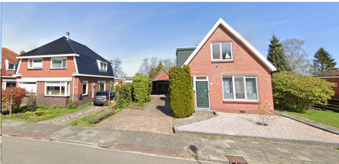
Figuur 2.4 Voorbeeld 2 Woning aan de Burgemeester van Royenstraat (Bron: Google Streetview)
