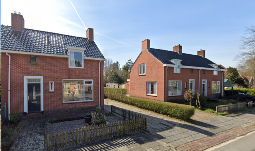
Figuur 2.3 Voorbeeld 1 woning aan de Burgemeester van Royenstraat (Bron: Google Streetview)
