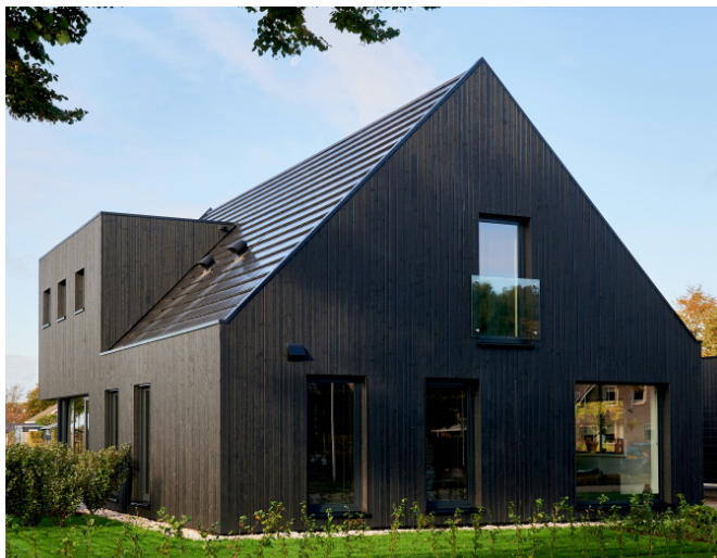
Voorbeeld van donker en natuurlijk materiaalgebruik en een passende dakopbouw. Bron: Kwint Architecten.
