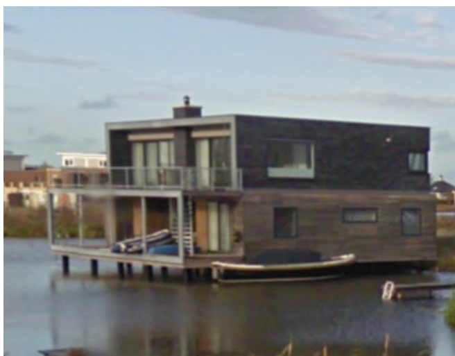
Voorbeeld van kantige vormgeving, de toepassing van natuurlijk gevelmateriaal en een meeontworpen terras/vlonder. Bron: Google Maps.
